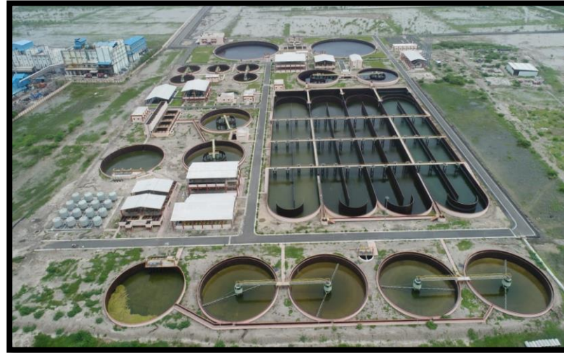
Dahej CETP – 40 MLD
